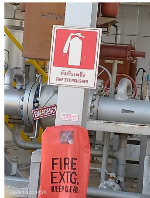
ภาพที่ 2-37 เครื่องดับเพลิงชนิดผง (Powder Extinguisher) บริเวณสถานีควบคุมก๊าซ
