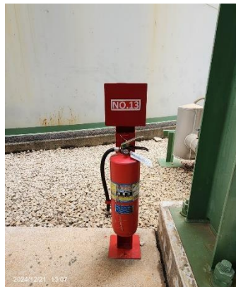
ภาพที่ 2-37 เครื่องดับเพลิงชนิดผง (Powder Extinguisher) บริเวณสถานีควบคุมก๊าซ
