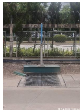
ภาพที่ 2-9 ประตูละบายน้ำของรางระบายน้ำฝน
