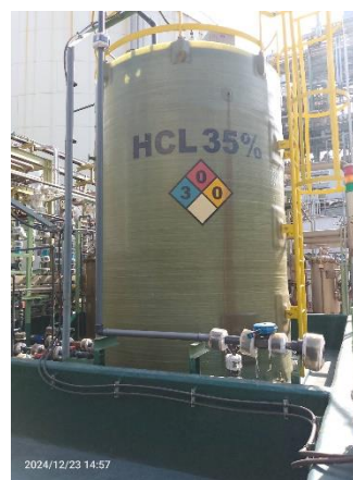
ภาพที่ 2-28 ถังเก็บสารละลายกรดไฮโดรคลอริก
