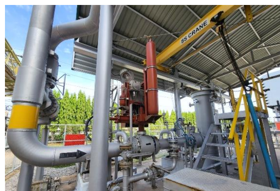
ภาพที่ 2-36 วาล์วควบคุมการจ่ายก๊าซ
