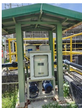
ภาพที่ 2-3 การติดตั้งอุปกรณ์เพื่อนำน้ำทิ้งกลับมาใช้ ประโยชน์
