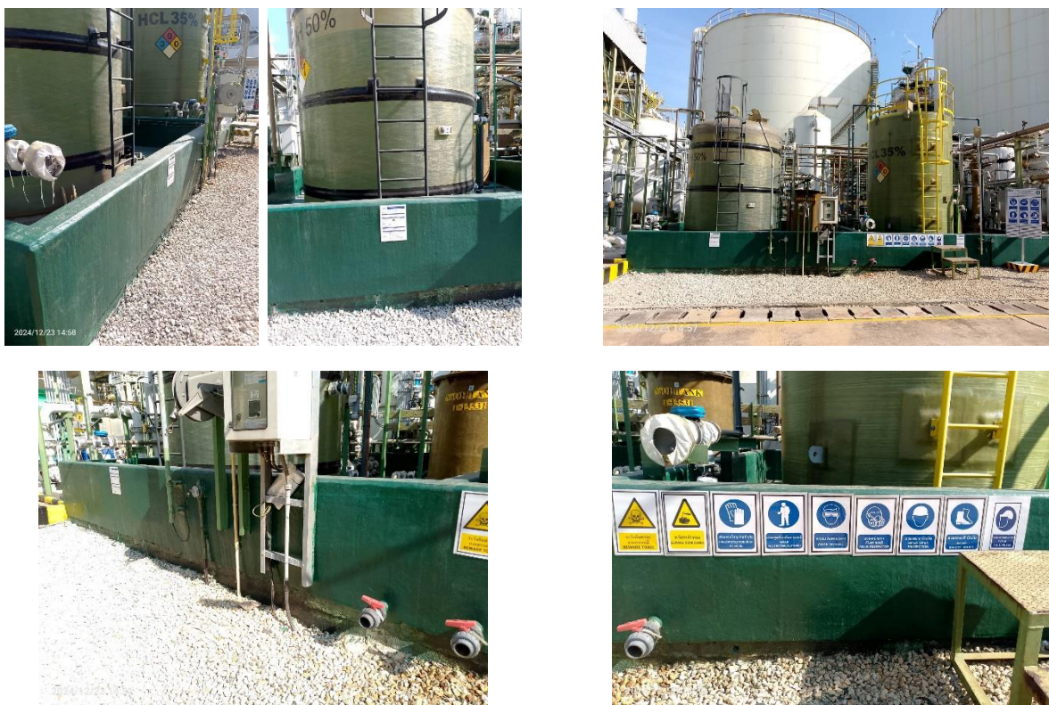
ภาพที่ 2-26 คันคอนกรีตป้องกันการหกรั่วไหลของสารเคมี
