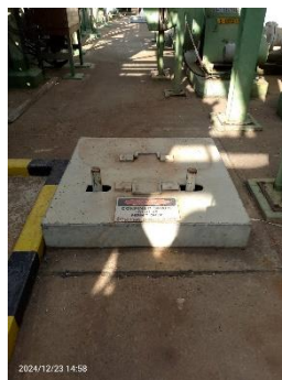
ภาพที่ 2-7 ถังแยกน้ำ-น้ำมัน
