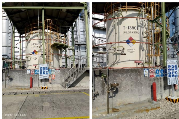
ภาพที่ 2-30 ถังเก็บสารละลายแอมโมเนียมไฮดรอกไซด์
