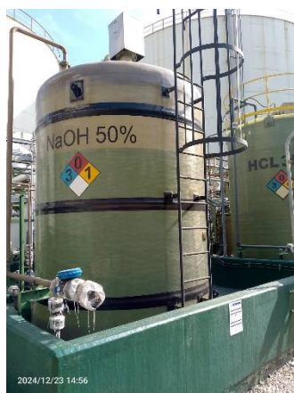
ภาพที่ 2-27 ถังเก็บสารละลายโซเดียมไฮดรอกไซด์
